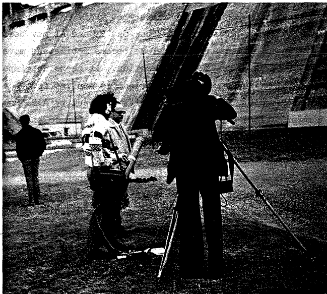
Val de la Mare Dam
